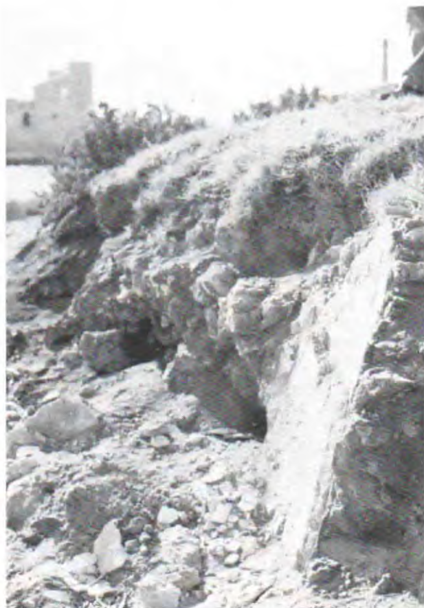
Fig. 10 - Torre Vindicari. Si noti la parte rivestita di malta delle vasche circolari, distrutta dall'erosione marina
