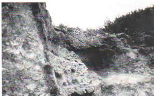
Fig. 16 - La parete rivestita di malta di una delle vasche circolari. A metà altezza circa uno scolino avrebbe potuto sostenere una struttura mobile
