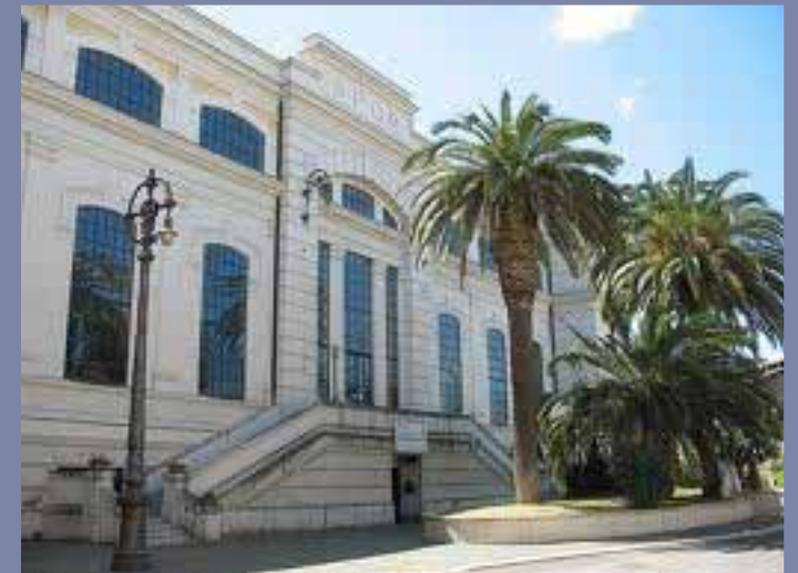
Roma, Centrale Montemartini, veduta esterna.
