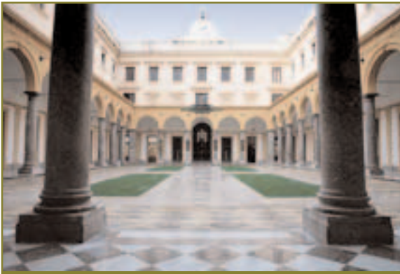
Chiostro del Convento dei Teatini, oggi atrio della Università, realizzato con colonne in pietra di Billiemi
