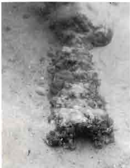
FIG. 13. Tubo di ferro innestato in un incavo di una massiccia trave.
